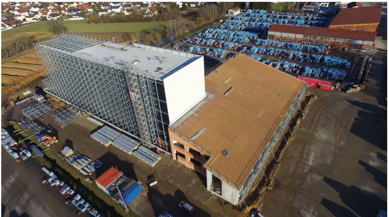
Aktueller Baufortschritt Januar 2023: Das Logistik-Zentrum bei ERLUS in Neufahrn entsteht. Drohnenfoto: ERLUS
